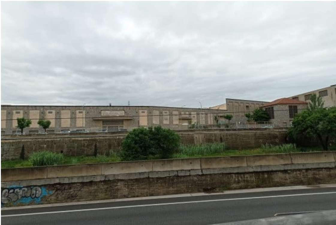
La nova estació de La Llana donaria servei a polígons i un futur complex residencial. Foto: Marta Casas
