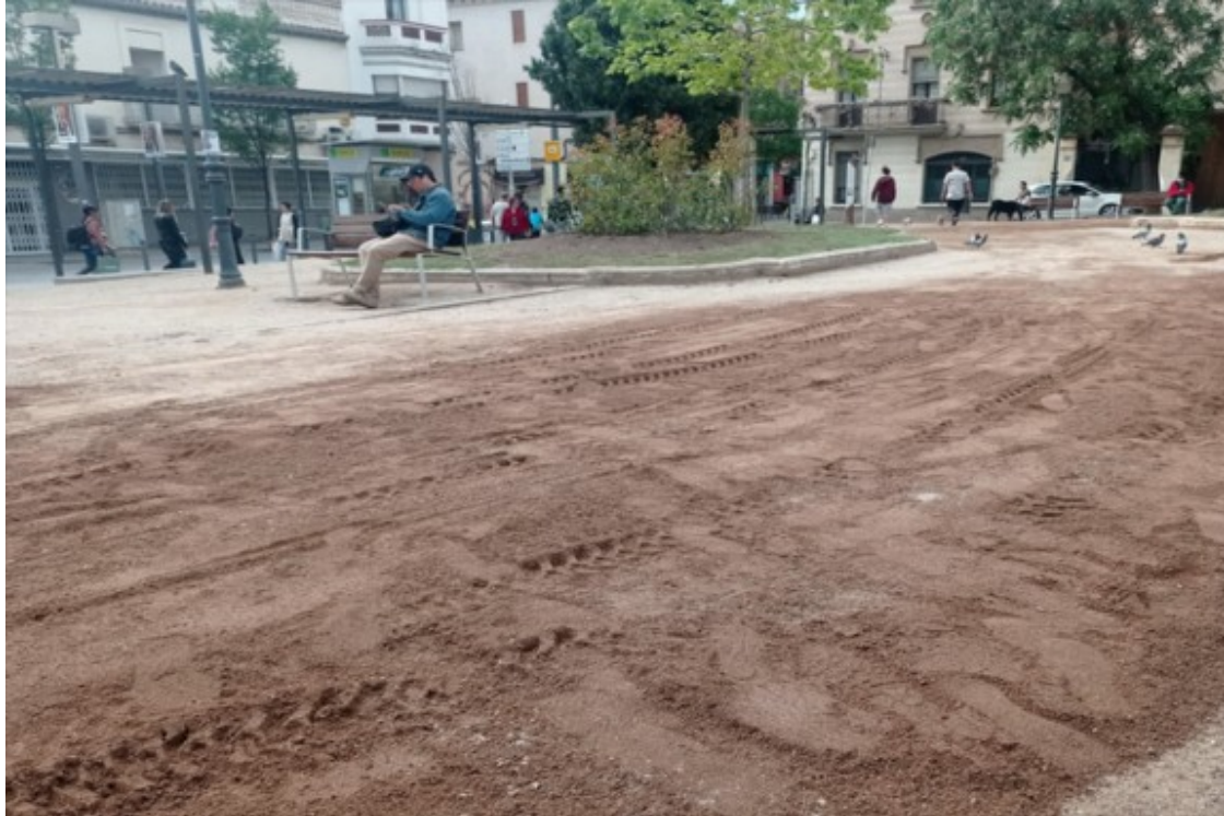
Obres de drenatge a la plaça Pearson Foto: Marta Casas
