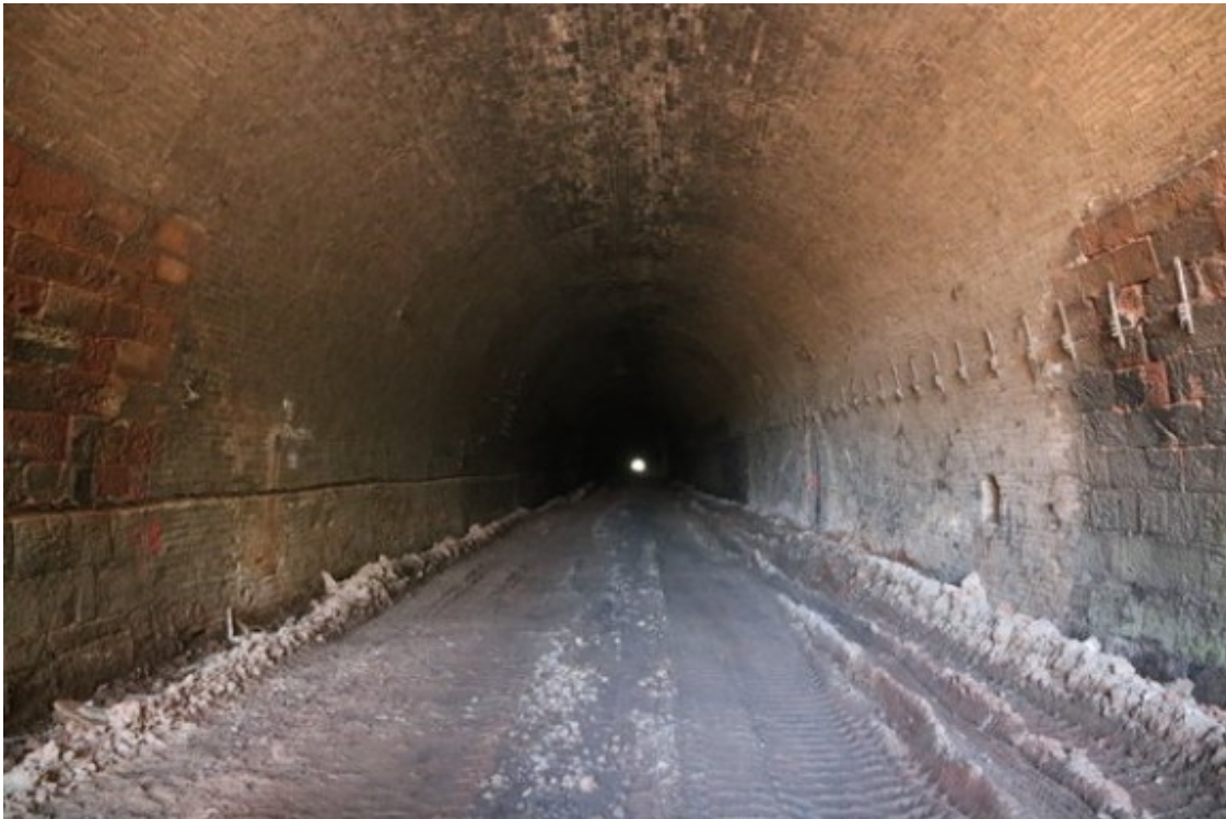
Interior del l'antic túnel de Castellbisbal Foto: ACN
