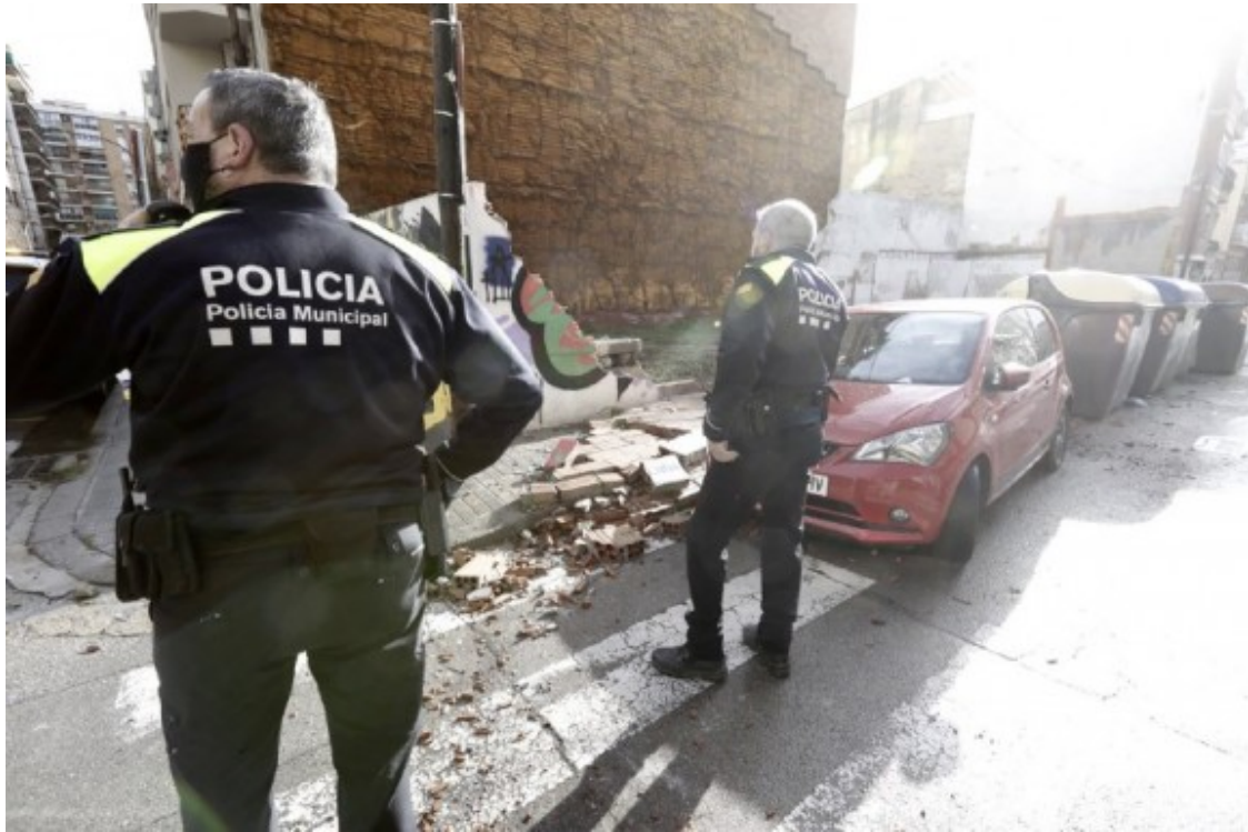
El mur del carrer Gorina i Pujol de Sabadell s'ha desmoronat Foto: Juanma Peláez
